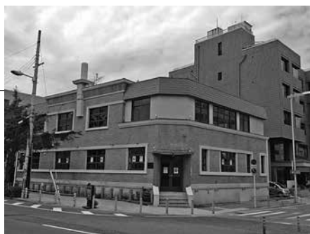
中谷運輸築港ビル
